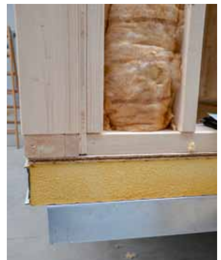
Dick isoliert: Außenwand und Bodenplatte.
