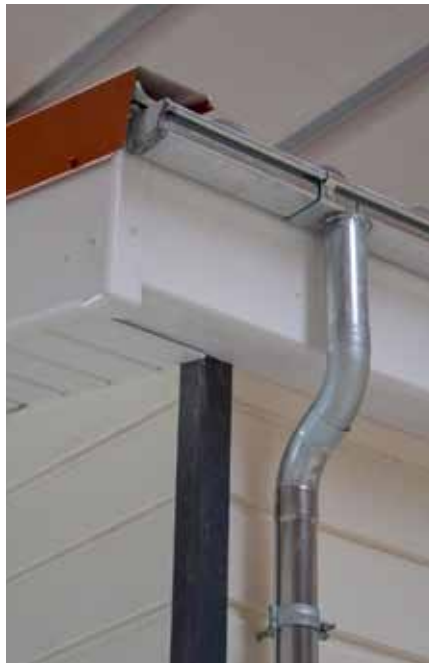
Bernd Götting Aus Metall: Dachrinnen und Fallrohre..
